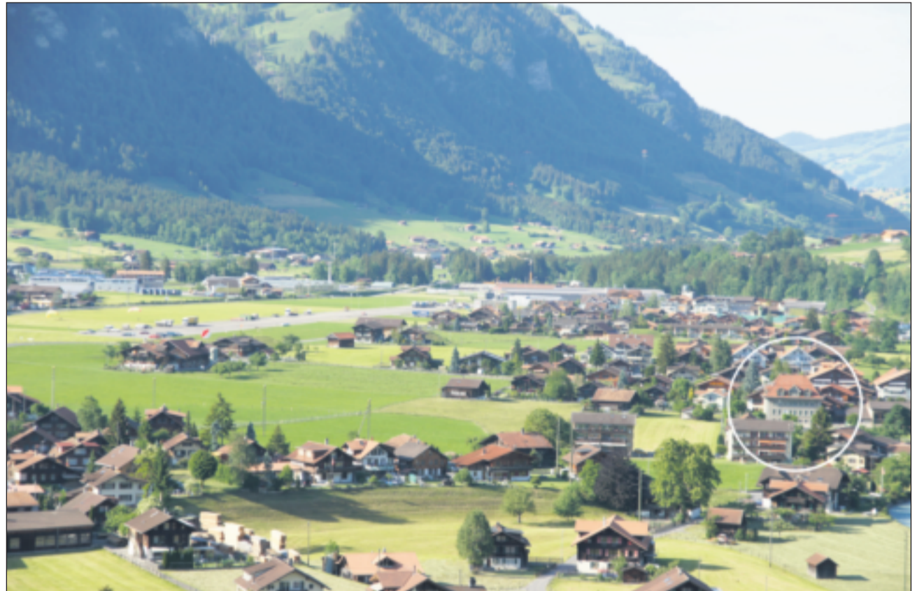
Im Gebiet Flugplatz – Brüggmatte wird in absehbarer Zukunft gebaut. Neben vier Industriebauten sollen auch 87 Wohneinheiten entstehen. Darum muss das Schulhaus Kanderbrück (weisser Kreis) dringend saniert und erweitert werden. BILD MARCEL MARMET
